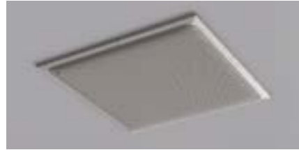
Montage au plafond
